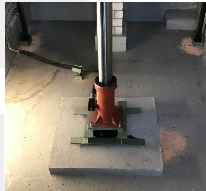
Abbildung 1: direkt angetriebener Hydraulikheber mit Erdschutzrohr
